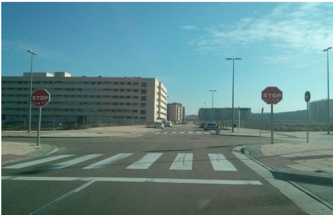
Avda. Cañones de Zaragoza / Avda. del Cierzo
